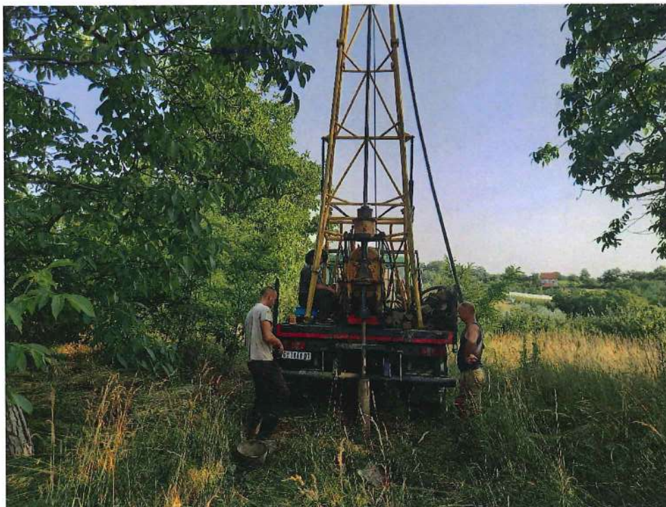
Слика 4: Истражно бушење за потребе трасе пута
